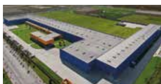
Hörmann Tianjin, Kína
